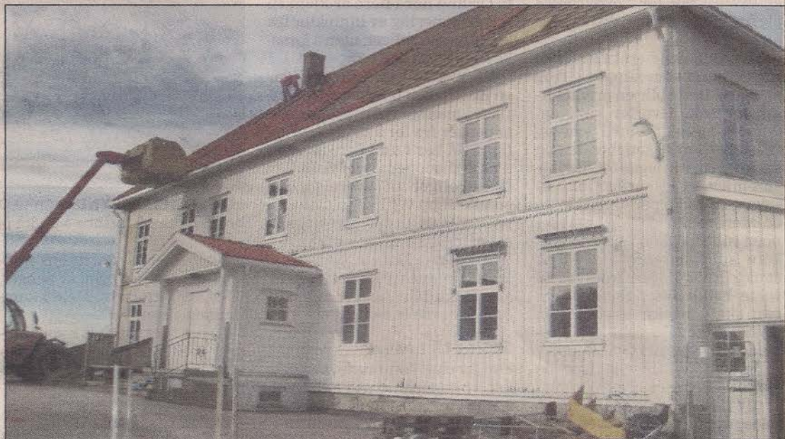
RIVES: Lørdag ble det startet med å fjerne takstein. I dag skal bygningen rives. Er det mulig at noen tar til fornuft før varige historiske verdier forsvinner, spør innsenderen.
